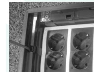
**7. Fijar la caja en el falso suelo mediante los tornillos de anclaje.**
